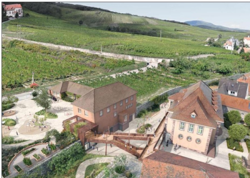
Vue aérienne du futur groupe scolaire, après réhabilitation. Document remis par Locus Architectes
